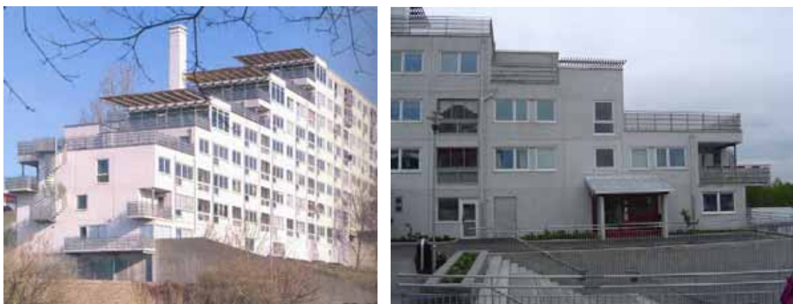
Figura 8. Blocos longos após intervenções com terraços, 2006 (Fonte: Frantidem, Autores)
