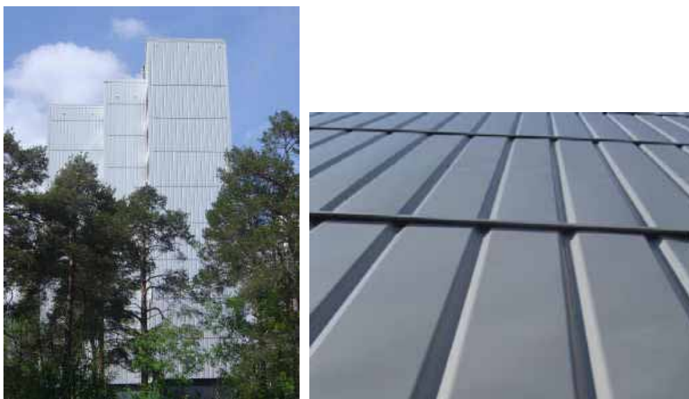
Figuras 21 e 22 Novo revestimento das torres, detalhe. (Fonte: Autores)
