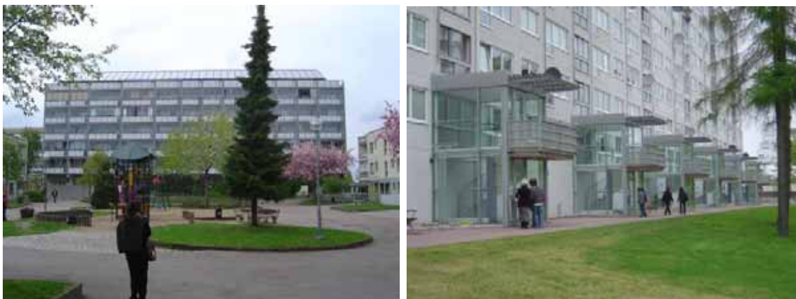
Figura 6, esquerda. Gårdsten, blocos de 5 andares com novas fachadas, 2006 (Fonte: Autores)
