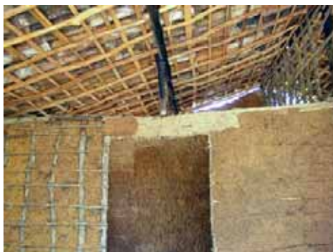
Fig. 5 – Exemplo contemporâneo da Taipa de sopapo. Arredores de Olinda. Fonte: Roberto Dantas/2005
