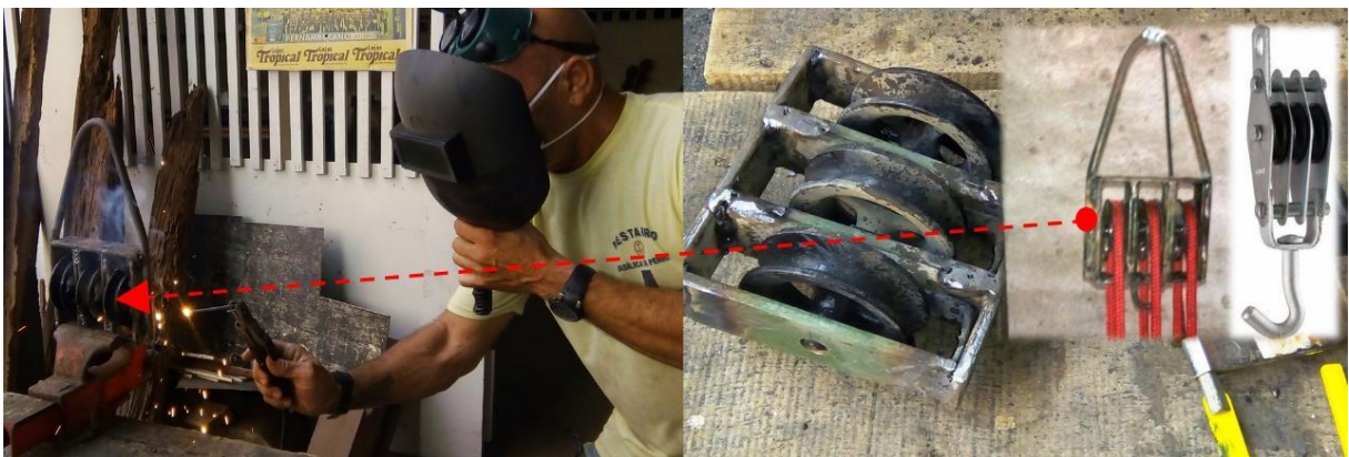
Fig. 9 – Fabricação de moitão para 1,2 ton em canteiro de serviços para descida e subida do sino.
