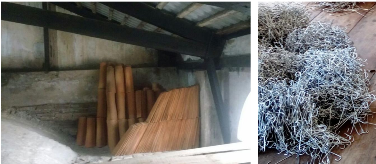
Fig. 6 e 7 – Reserva de telhas artesanais, tradicionais, para garantia de substituições por ocasião das manutenções periódicas, guardadas no intradorso do telhado da Basílica da Penha (Recife). Reserva de ganchos para aramagem de telhas guardadas no intradorso do telhado da Igreja da Madre Deus (Recife).
