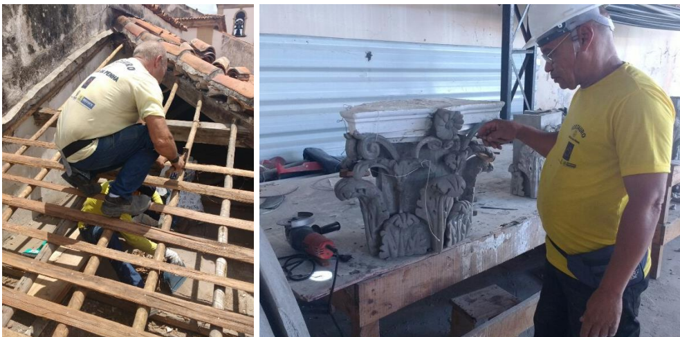
Fig. 4 e 5 – Manutenção no telhado da Igreja da madre Deus no Recife (PE) com a expertise do mestre carpinteiro José Floriano de Arruda Neto 7 e substituição de ornatos na Basílica da Penha pelo mestre estucador José Queiroz.
