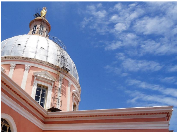
Fig. 3 – Instalação de uma escada de acesso ao cupolim da Basílica de Nossa Senhora da Penha do Recife (PE). Indispensável às inspeções e manutenções periódicas devido à altura e às condições de elevada salinidade do ambiente.
