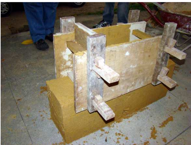
Img. 5 - Processo de confecção de taipa-de-pilão para procedimentos de enxertos e próteses. Fonte: Curso Gestão de Restauro/CECI/nov2009
