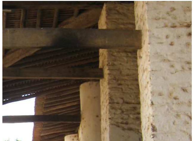
Img. 4 - Detalhe da alvenaria de tijolos da moita do Engenho Poço Comprido. Fonte: CECI/nov2008
