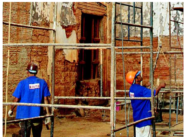
Img. 6 - Refazimento de taipa-de-pilão e de alvenarias de tijolos adobe no restauro da Matriz de Pirenópolis, Goiás. Fonte: Adriano Assunção/Biapo/2007.
