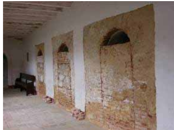
Fig. 7 e 8 – Extensão das prospecções numa das ilhargas da nave e parede do claustro. Fonte: CECL, mai/2007.
