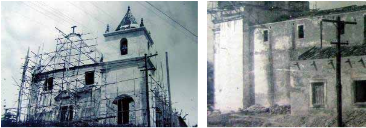
Fig. 1 e 2 - Prospecções arquitetônicas, através a demolição dos rebocos da Igreja de São João dos Militares (Olinda/PE), quando das intervenções de restauro entre 1943/46. Fonte: Arquivo 5º SR/IPHAN.
