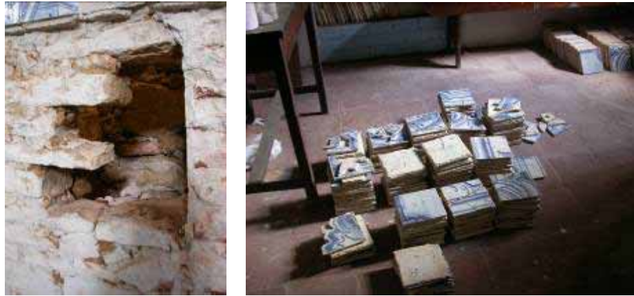
Fig. 9 e 10 – aspectos das alvenarias de fechamentos dos antigos vãos, mostrando o nível de invasão das prospecções; os azulejos removidos encontram-se numa antiga cela do convento sem proteção das faces (vidrado e chacota) e segurança. Fonte: CECI/maio-2007.
