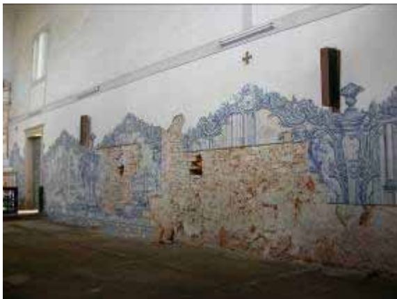
Fig. 7 e 8 – Extensão das prospecções numa das ilhargas da nave e parede do claustro. Fonte: CECL, mai/2007.
