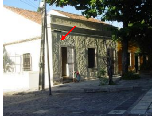
Imagem 2: Imóvel com a substituição do reboco tradicional, levando à perda da autenticidade (2007).
