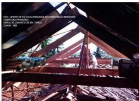
Figura 57 - Assentamento do telhamento em chapas de ferro galvanizado Foto: Tinoco, 1989
