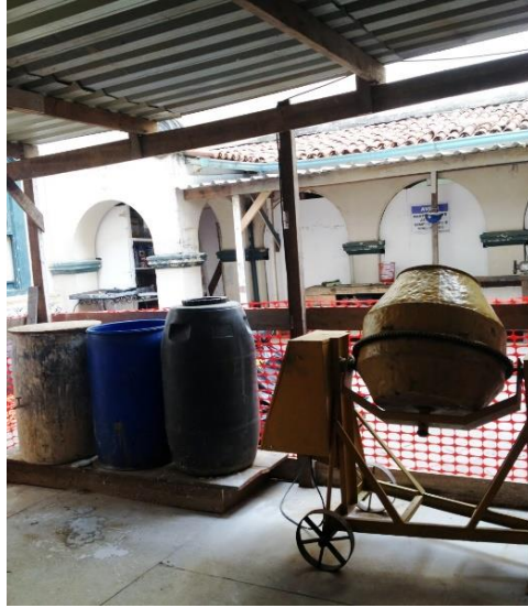
Figura 67 - Exemplo de galpão aberto para central de argamassa
