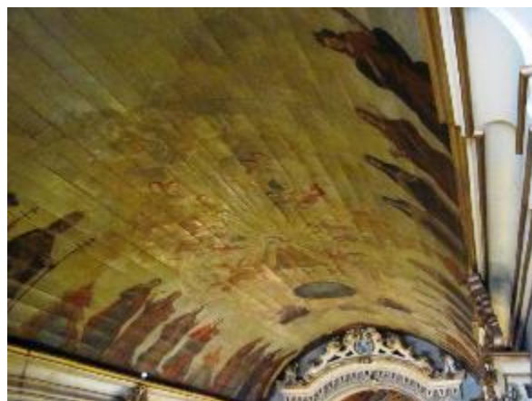
Figura 34 - Trecho do forro da nave
