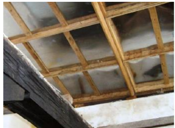
Figura 63 - Vista interna do telhamento modulado de chapas de ferro galvanizado Fonte: CECI, 2008
