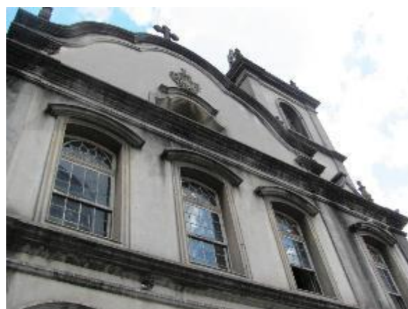
Figura 6 - Detalhe da fachada frontal
