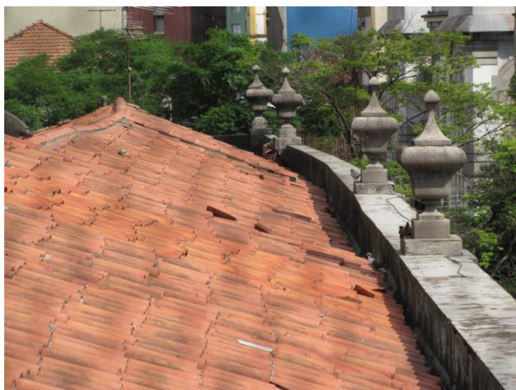
Figura 51 - Trecho da situação existente da cobertura À direita, platibanda em alvenaria onde serão fixados os pontaletes da cobertura provisória. Devem ser previstos os devidos recortes na estrutura e telhamento em função dos pináculos de cantaria.
