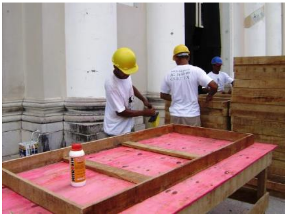
Figura 60 - Armação em madeira do telhamento modulado da cobertura provisória Fonte: CECI, 2008
