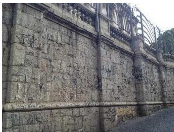
Figura 7 - Muro de pedra na divisa frontal do terreno
