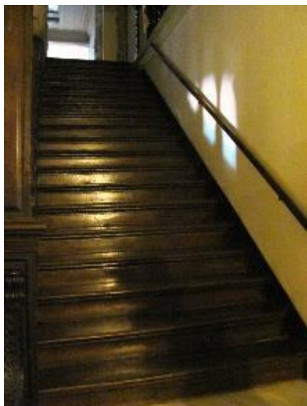
Figura 27 - Escada de acesso ao pavimento superior
