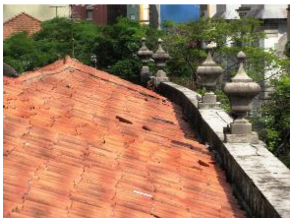
Figura 43 - Trecho da cobertura
