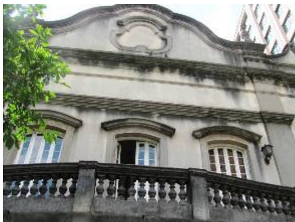
Figura 13 - Trecho da fachada posterior
