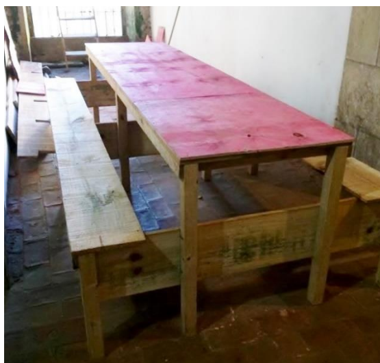
Figura 90 - Exemplo de mesa para refeitório confeccionada na obra
