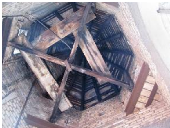
Figura 40 - Vista interna da torre sineira
