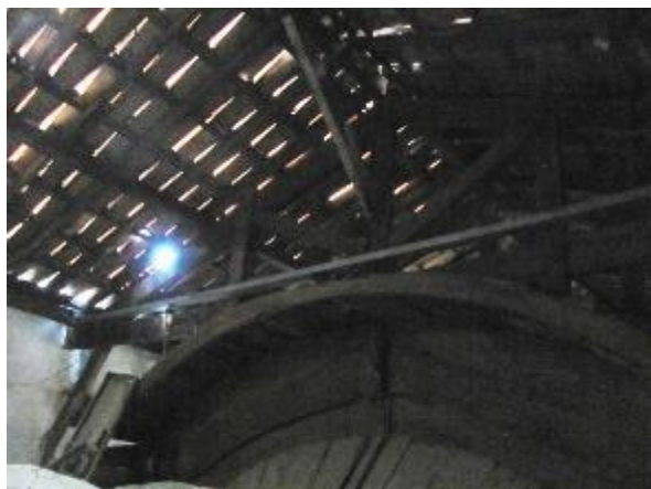
Figura 39 - Estrutura da cobertura
