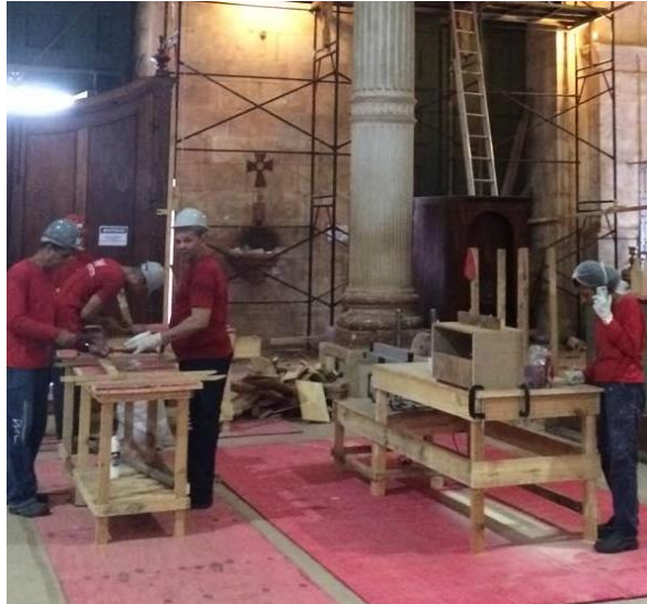
Figura 107 - Exemplo de proteção de piso com chapa compensada
