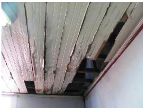
Figura 37 - Forro do pavimento superior
