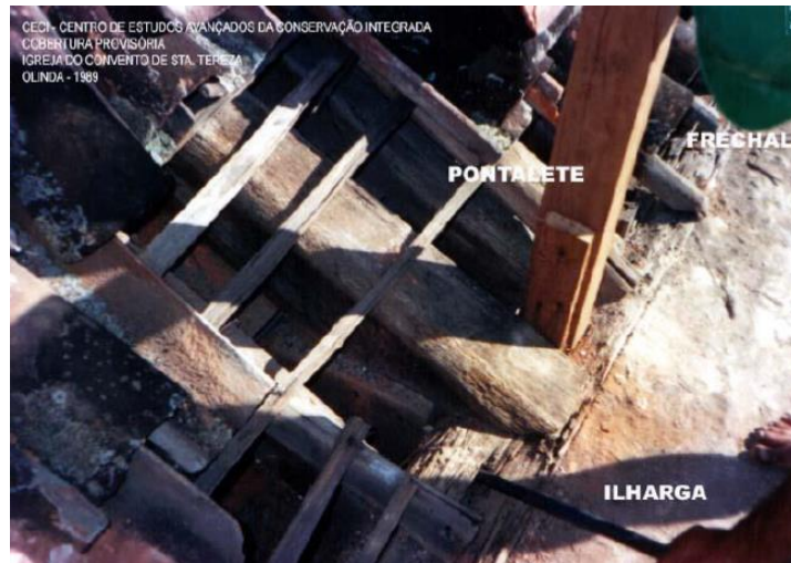
Figura 54 - Fixação do pontalete nas ilhargas da nave, apoiado sobre o frechal. Foto: Tinoco, 1989
