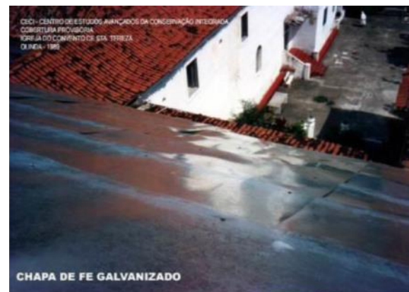
Figura 58 - Aspecto do telhamento da cobertura provisória Foto: Tinoco, 1989
