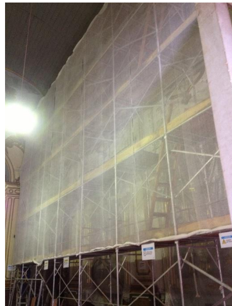
Figura 72 - Andaime interno após a instalação de telas de proteção Obra de restauração da Igreja da Ordem Terceira de São Francisco - São Paulo, 2013
