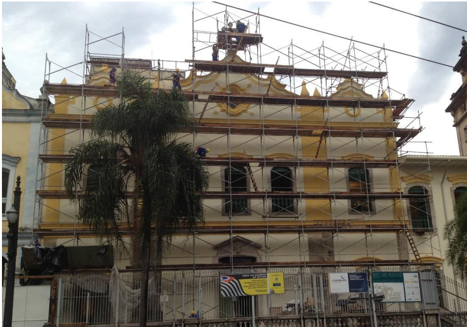
Figura 70 - Exemplo de andaime fachadeiro instalado para restauro de fachada Obra de restauração da Igreja da Ordem Terceira de São Francisco - São Paulo, 2013
