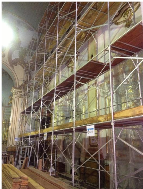
Figura 71 - Exemplo de andaime interno para restauro de paredes e elementos artísticos Obra de restauração da Igreja da Ordem Terceira de São Francisco - São Paulo, 2013
