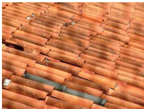
Figura 44 - Detalhe das telhas
