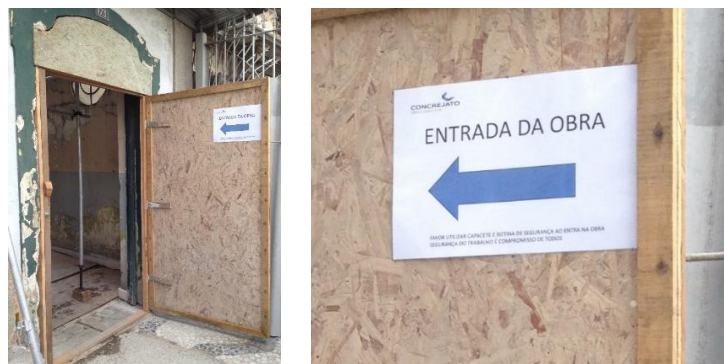
Figura 97 e 98 - Exemplo de sinalização direcional na entrada da obra
