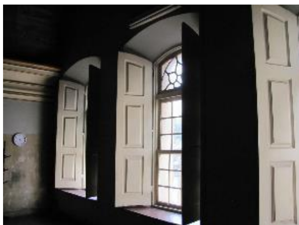
Figura 35 - Esquadrias do coro
