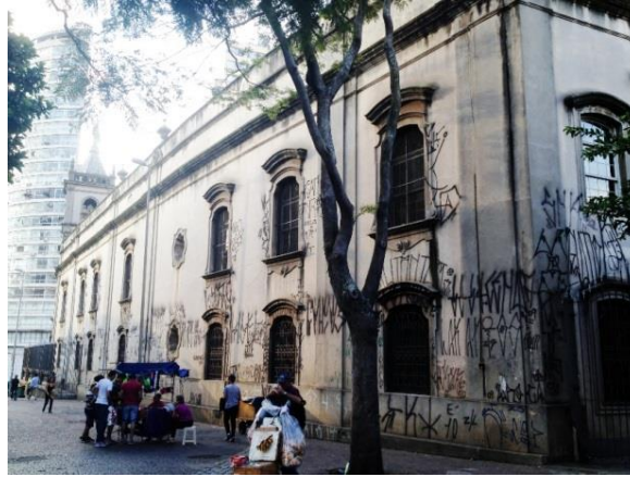
Figura 47 - Trecho do calçadão na lateral da igreja onde será instalado o tapume
