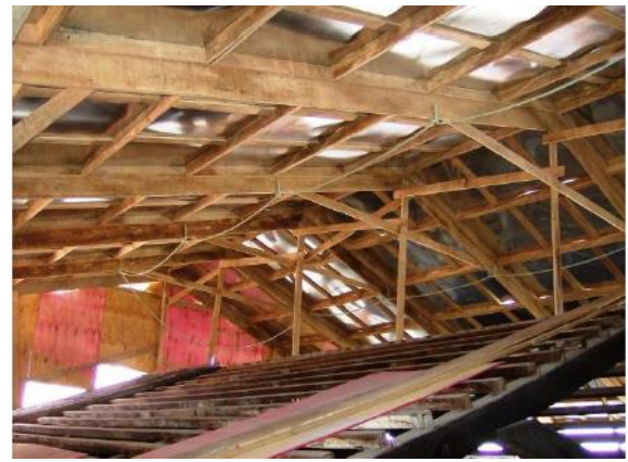
Figura 61 - Interior da cobertura provisória Fonte: CECI, 2008
