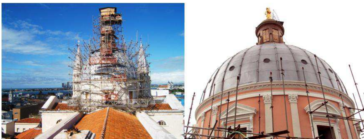
Fig. 18 – Megaestrutura de andaimes para o restauro da cúpula e instalação de pontos de acessibilidade para as manutenções. Foto realizada pelo autor, ago.2008
