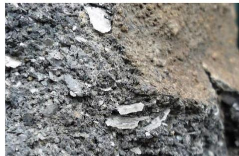
Fig. 07 – Idem. Detalhe da argamassa, sendo bem visíveis os grãos de mica (malacacheta) envolvidos pelas granilhas de granito.
