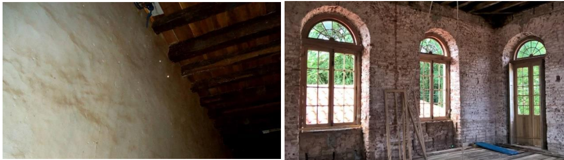
Fig. 6 e 7 – Parede de reboco tradicional a base de cal e areia, estucado (6). Rebocos removidos (7). Acervo do autor.
