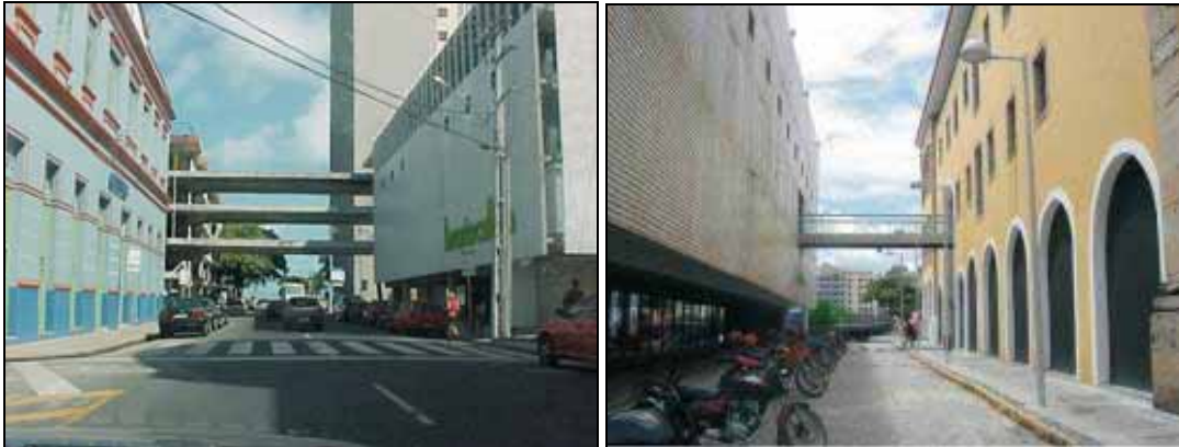
Figura 34 e 35 – Passarelas entre os edifícios-garagem e entre o Paço e o edifício-garagem (In: TRINDADE, 2007; Diana Zárate, 2007).
