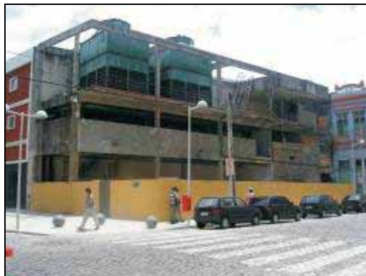
Figura 36 – Central de ar-condicionado (Diana Zárate, 2007).
