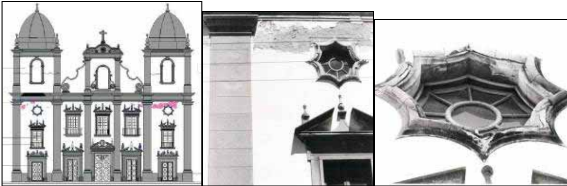
Figura 8 - Levantamento do estado da fachada principal (Acervo L'Amour e Campelo, 2003).
