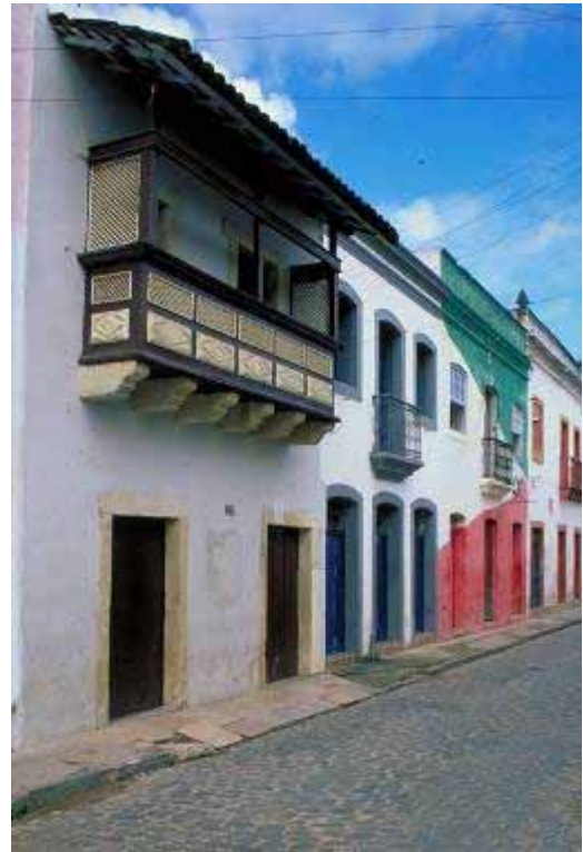
Figura 3: Casario da Rua do Amparo Fonte: 5ª. SR/IPHAN
