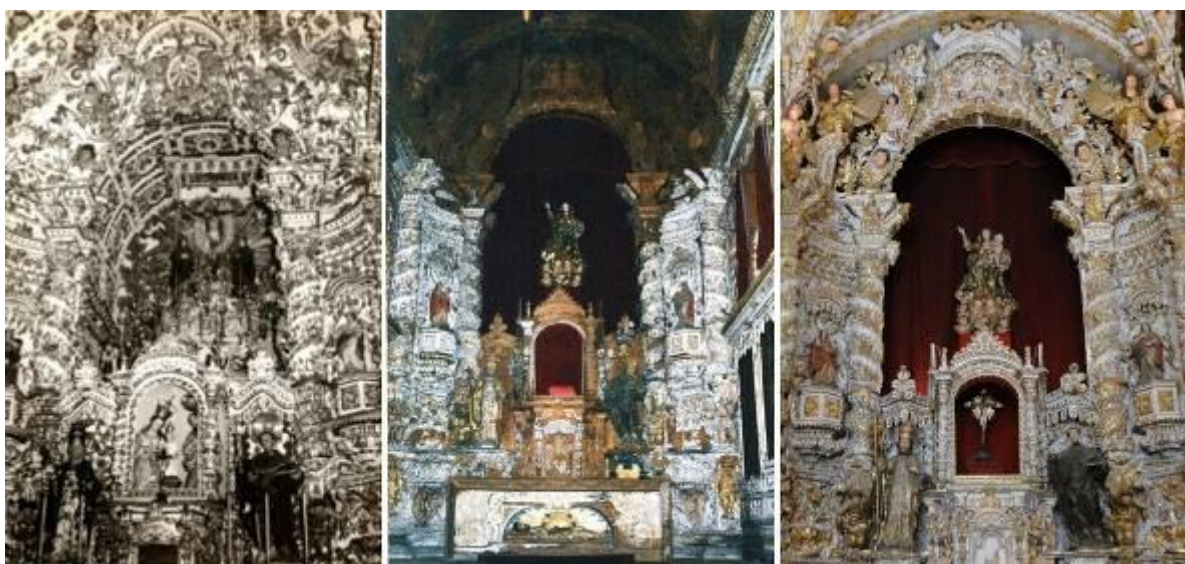
Fig. 02 – Aspectos antes do incêndio (1971), restauro do IPHAN-PE (1984), restauro PRONAC (2005) do retábulo e dos ornamentos em madeira talhada da Capela Mor da Igreja da Madre Deus do Recife. Fonte: Débora Assis Mendes, 2006.
