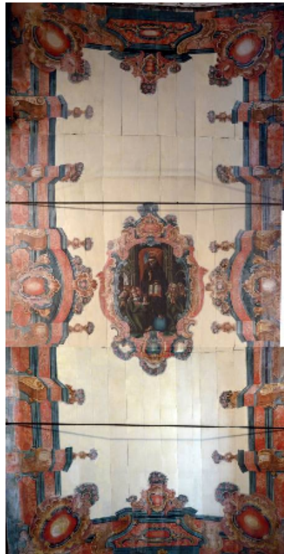
Imagem 4: Forro da Capela dos Noviços após restauro. Fonte: Ceci (2006)
