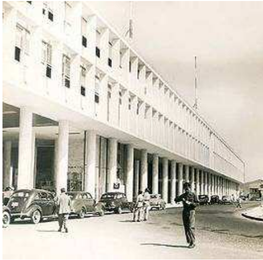
Fachada da estação de passageiros
