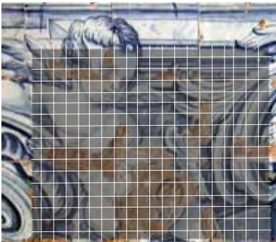
Faceamento - Procedimento técnico para garantir a integridade e proteção provisória dos materiais fragilizados com riscos de perdas, de fácil aplicação e remoção.
